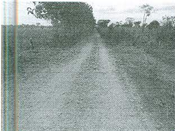
FOTO - PT 11- LH 24 KM 37 REF 5.6 KM SENTIDO RO473
