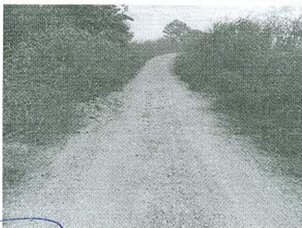
FOTO - PT 12-LH 24 KM 37 REF 11 KM SENTIDO RO 473
