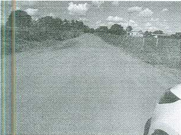
FOTO - PT 15- LH 16 KM 22 REF 1.6 KM SENTIDO 22
