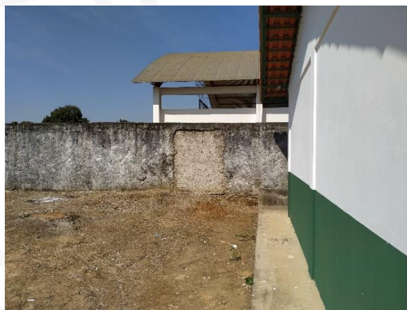
Figura 3: Detalhe de do Muro e lateral
