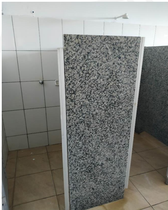
Figura 10: Divisória dos banheiros
