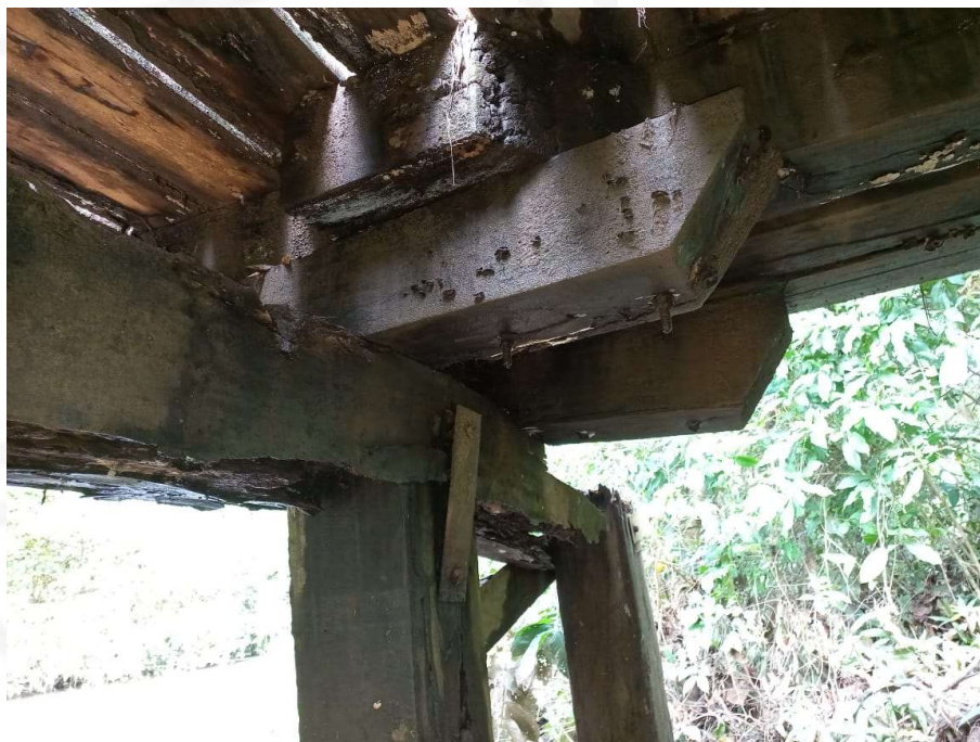
Figura 6 - Mesoestrutura da antiga ponte
