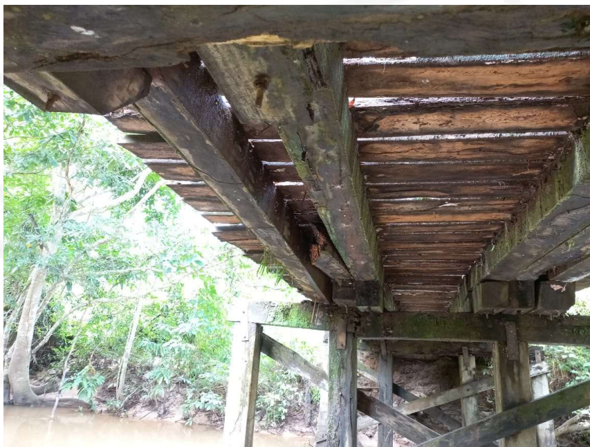
Figura 9 - Infraestrutura, mesoestrutura e superestrutura da antiga ponte
