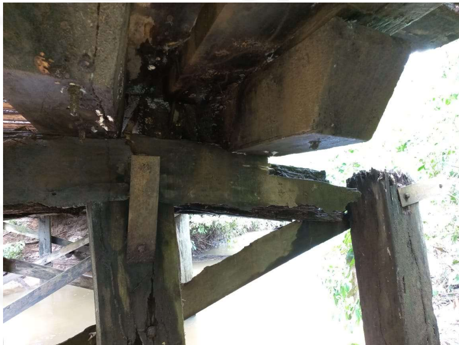
Figura 8 - Mesoestrutura da antiga ponte
