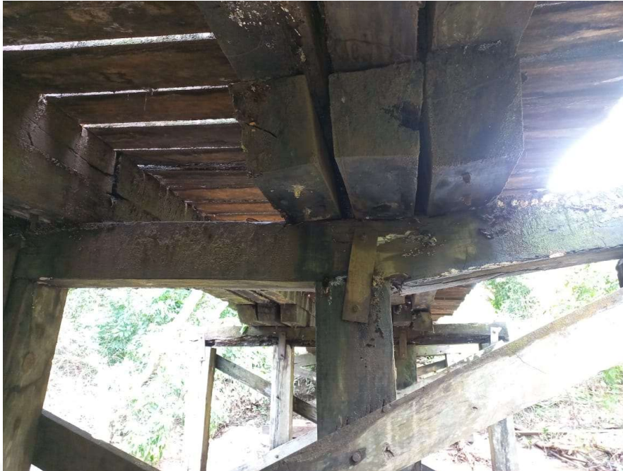
Figura 1- Infraestrutura e mesoestrutura da antiga ponte
