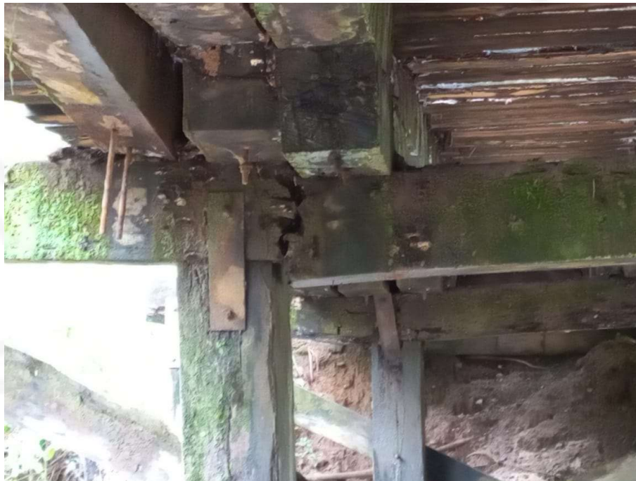
Figura 3 - Mesoestrutura da antiga ponte
