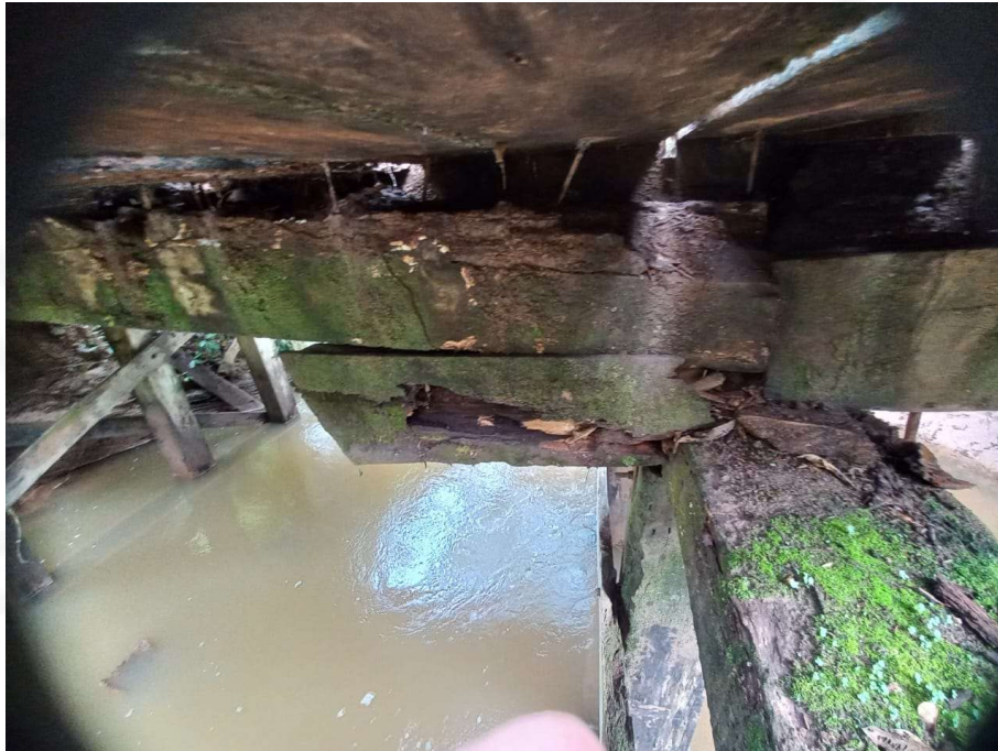
Figura 7 - Mesoestrutura da antiga ponte
