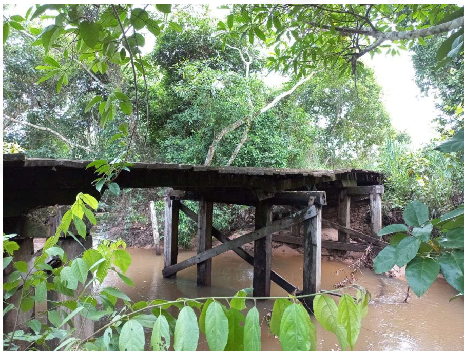
Figura 5 - Superestrutura da antiga ponte
