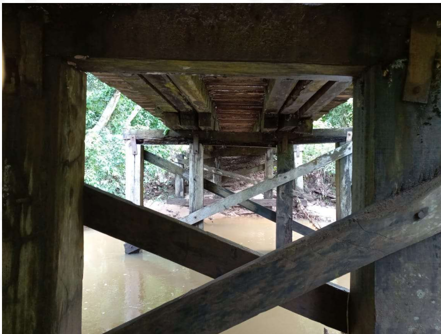
Figura 2 - Infraestrutura e mesoestrutura da antiga ponte
