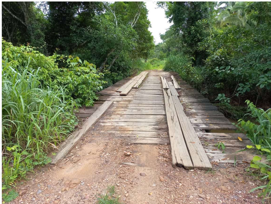
Figura 4 - Superestrutura da antiga ponte
