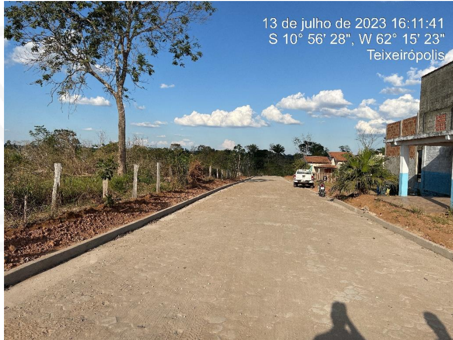
Figura 11: Rua Projetada 01 (setor 09) executada;
