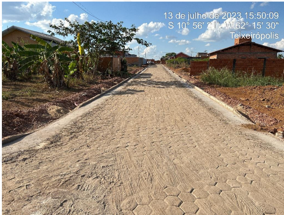
Figura 3: Piso intertravado executado na Rua Projetada 02;
