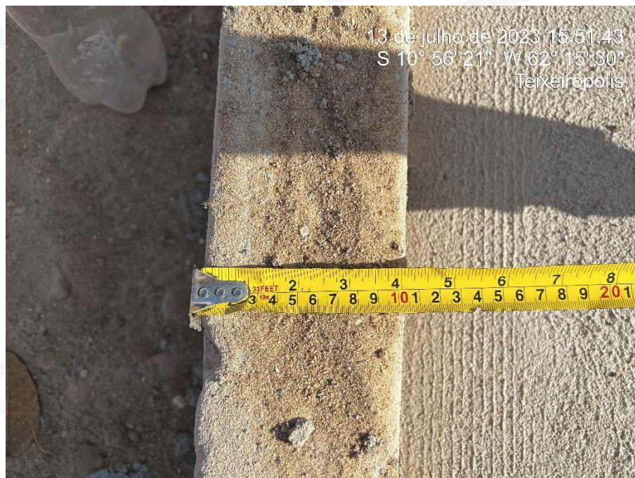
Figura 5: Medida da sarjeta de acordo com projeto na Rua Projetada 02;
