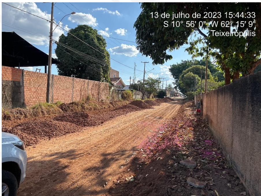
Figura 14: Terraplanagem Rua Duque de Caxias;
