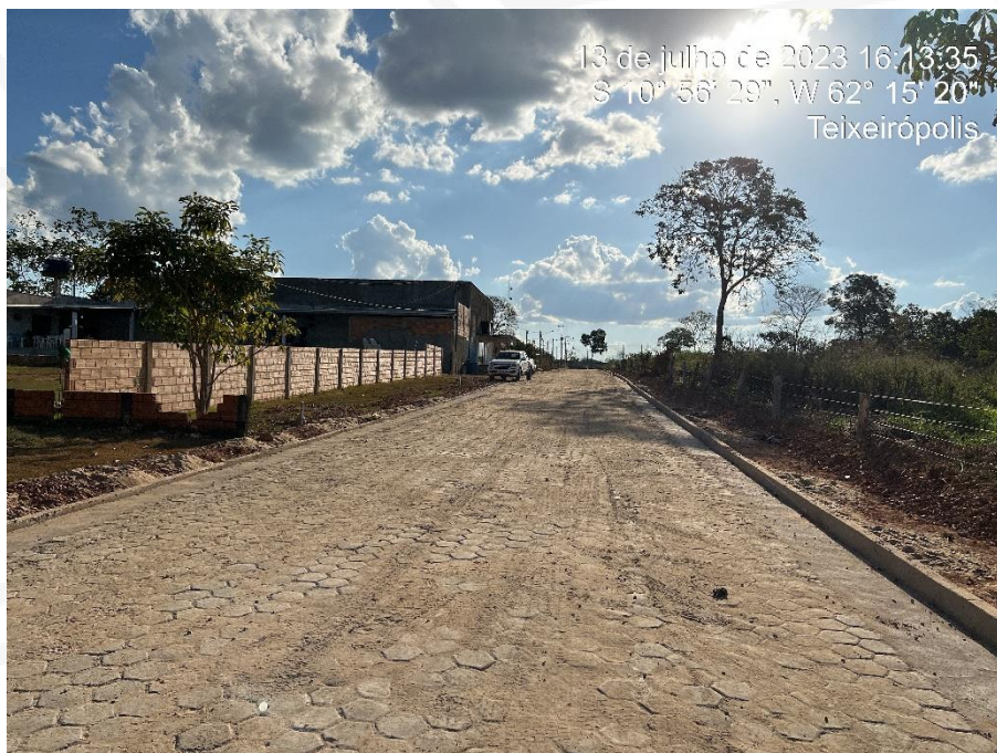
Figura 10: Rua Projetada 01 (setor 09) executada;
