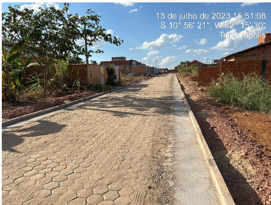
Figura 4: Piso intertravado executado na Rua Projetada 02;
