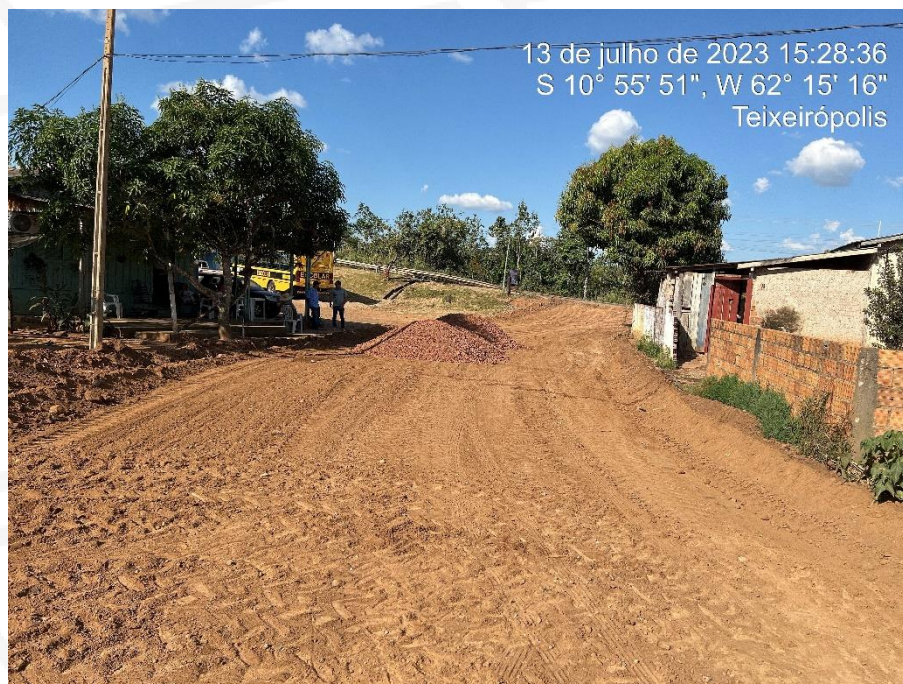
Figura 2: Terraplanagem Rua do Contorno;
