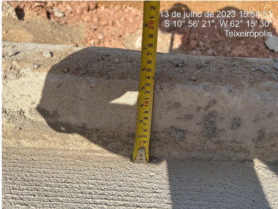
Figura 7: Altura Meio-Fio Rua Projetada 02;
