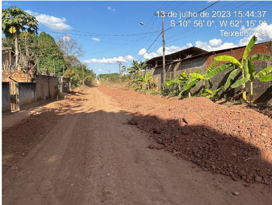
Figura 13: Terraplanagem Rua Duque de Caxias;
