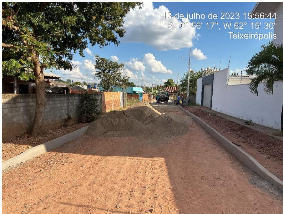
Figura 8: Rua Projetada 01 sendo executada;
