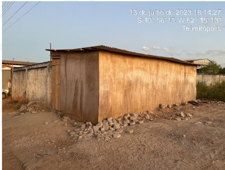
Figura 14: Depósito de materiais;
