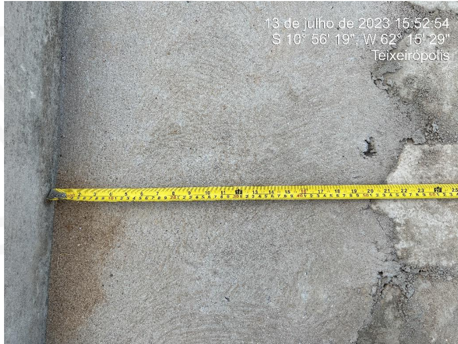
Figura 5: Medida da sarjeta de acordo com projeto na Rua Projetada 02;
