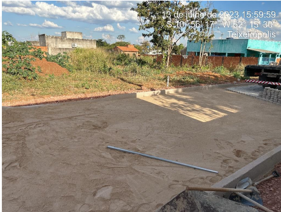
Figura 9: Rua Projetada 01 sendo executada;
