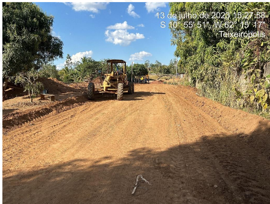
Figura 1: Terraplanagem Rua do Contorno;
