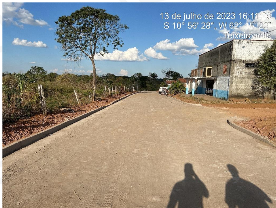
Figura 12: Rua Projetada 01 (setor 09) executada;
